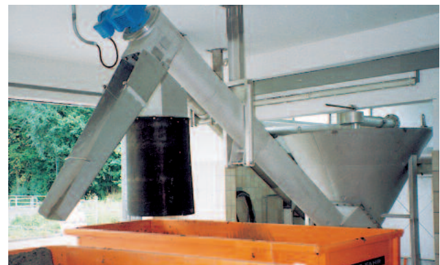
Lajitinruuvi kuljettaa hiekan erotussäiliöstä lavalle.
