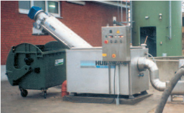
ROTAMAT® Sakokaivolietteen vastaanottoasema Ro 3.1 jossa ROTAMAT® Hienovälppä, eristetty ja lämmitetty ulkoasennusta varten
