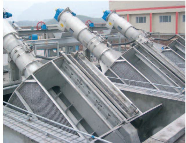
Kanavassa vierekkäisiä ROTAMAT® hienovälppiä
