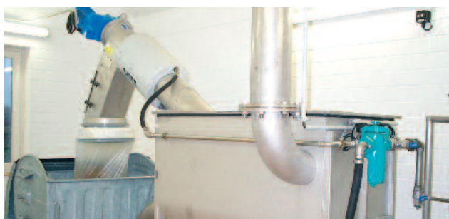
Барабанная решетка HUBER ROTAMAT®, смонтированная в резервуаре...
