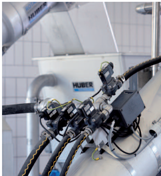
Барабанная решетка с вращающимся барабаном HUBER ROTAMAT® с интегрированной системой промывки отбросов IRGA
