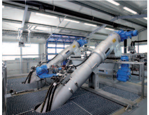
HUBER Membrane Screen ROTAMAT® RoMem Pro kifejezetten a hajszálak és rostos szálak leválasztásához
