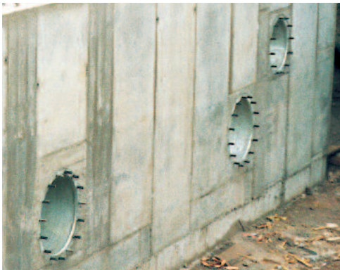
Zsaluzatba készített falátvezetés
