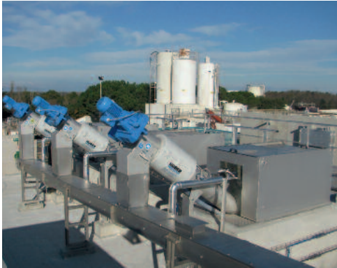
HUBER Szűrőberendezés ROTAMAT® STAR az utánakapcsolt membránberendezés védelme céljából
