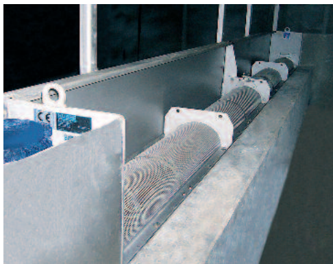
HUBER Szűrőberendezés ROTAMAT® RoK2: A tehermentesítő vízmennyiségének szűrése a túlfolyóküszöb előtt
