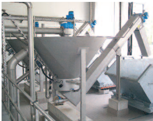
Innovatív technika: HUBER Coanda Homokmosó berendezés RoSF4
