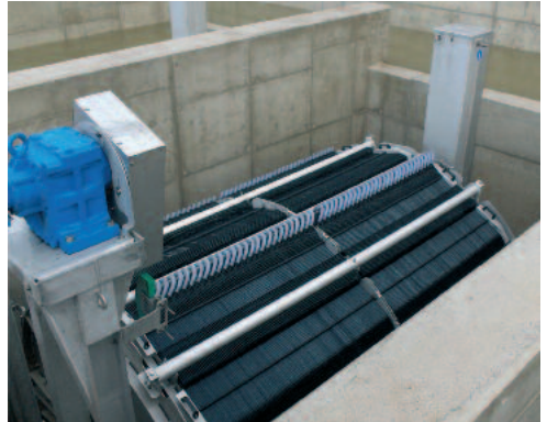
HUBER Membránszűrés VRM® 30 – Szűrőkamrába szerelt szűrőegység
