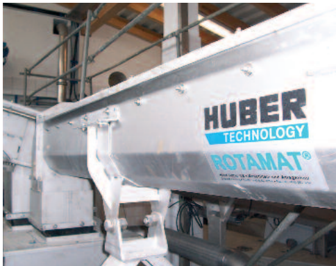
HUBER Szállítócsiga ROTAMAT® Ro8 / Ro8 t, mindennemű rácsszemét szállítására és beépítési helyzethez alkalmas
