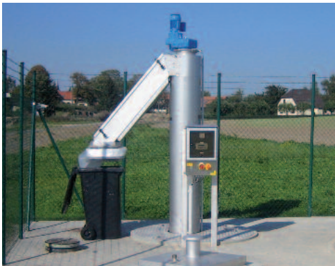
HUBER Aknaszűrőberendezés ROTAMAT® RoK4 fűthető szabadtéri felállítással
