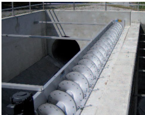
HUBER Szűrőberendezés ROTAMAT® RoK1: A tehermentesítő vízmennyiségének szűrése a túlfolyóküszöb után
