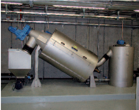
HUBER Csigás sűrítő S-DRUM – rendkívül robusztus sűrítő
