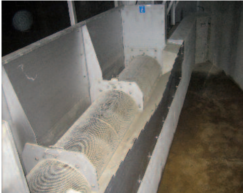
Kombinált tehermentesítő mennyiség mérése a HUBER ROTAMAT® RoK2 Szűrőberendezéssel
