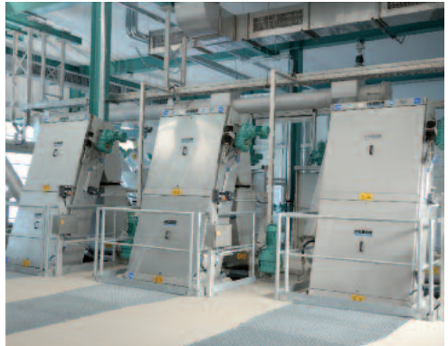
A HUBER RakeMax® körbefutó fésűs rács: megbízható és robusztus
