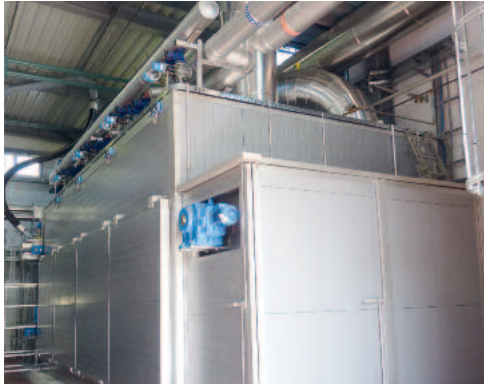
HUBER Szalagszárító BT a szennyvíziszap-szárításhoz > 90 % TS-ig
