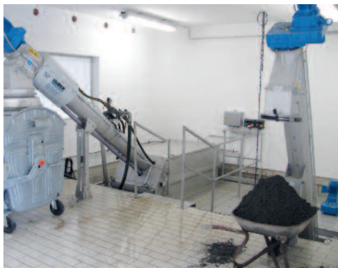
A homokfogóba integrált homokmosó
