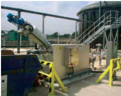
HUBER Fekáliaifogadó állomás ROTAMAT® Ro3.1 – szabadtéri iszapszűrés
