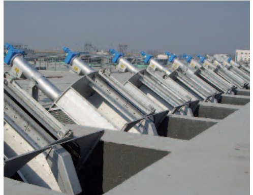
HUBER Finomrács ROTAMAT® Ro 1 csatornába ill. tartályba történő beépítéshez
