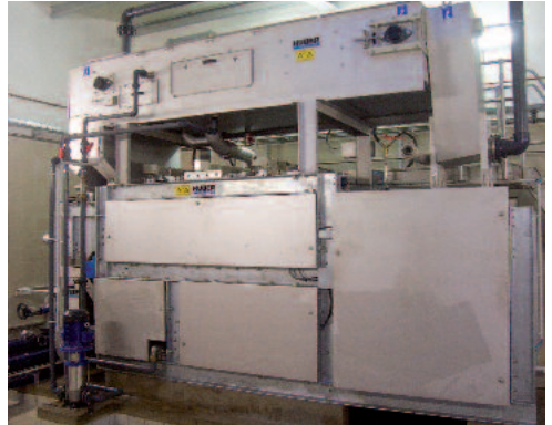
HUBER Íves szalagprés B-PRESS – nagy áteresztésekhez a HUBER Szalagszűrítő Drainbelt-tel kombinálható
