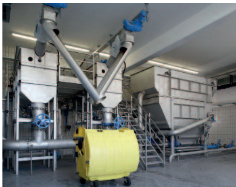
Szűrőberendezés a finomszűrés és a zsírleválasztó flotáció céljából a húsfeldolgozásban
