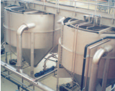
HUBER körhomokfogó HRSF üzemelés közben
