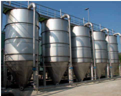
HUBER CONTIFLOW® Homokszűrő nemesacélból készült változata
