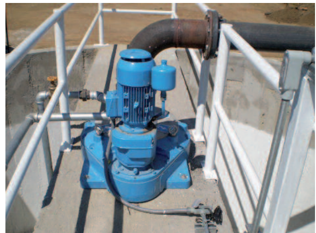
Sekoittajassa on luotettava vaihdemoottori, jossa pieni vetohammasyöry ja iso vastahammasyöry (Bull Gear).
