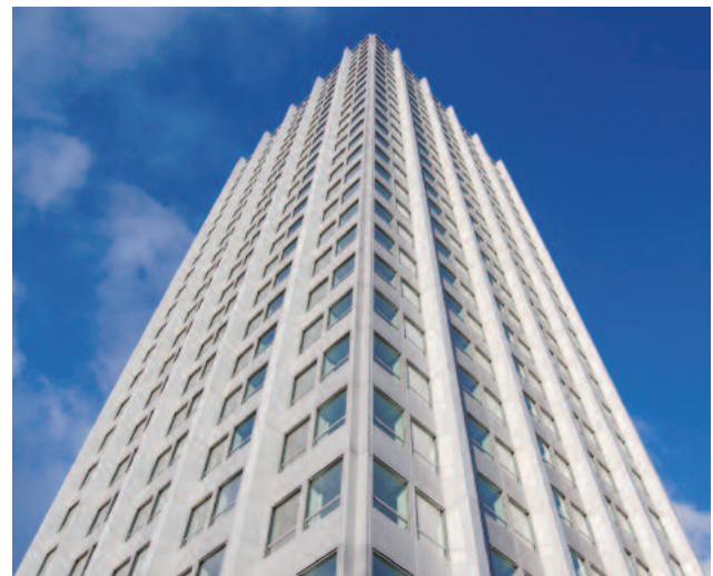
Winterthur Wintower rakennuksen ilmastointi HUBER ThermWin® järjestelmällä
