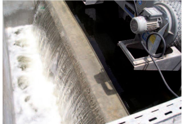
Kirkas ja melkein kokonaan kiintoaineeton ulosvirtaus RoDisc® pyörivästä mikrosiivilästä
