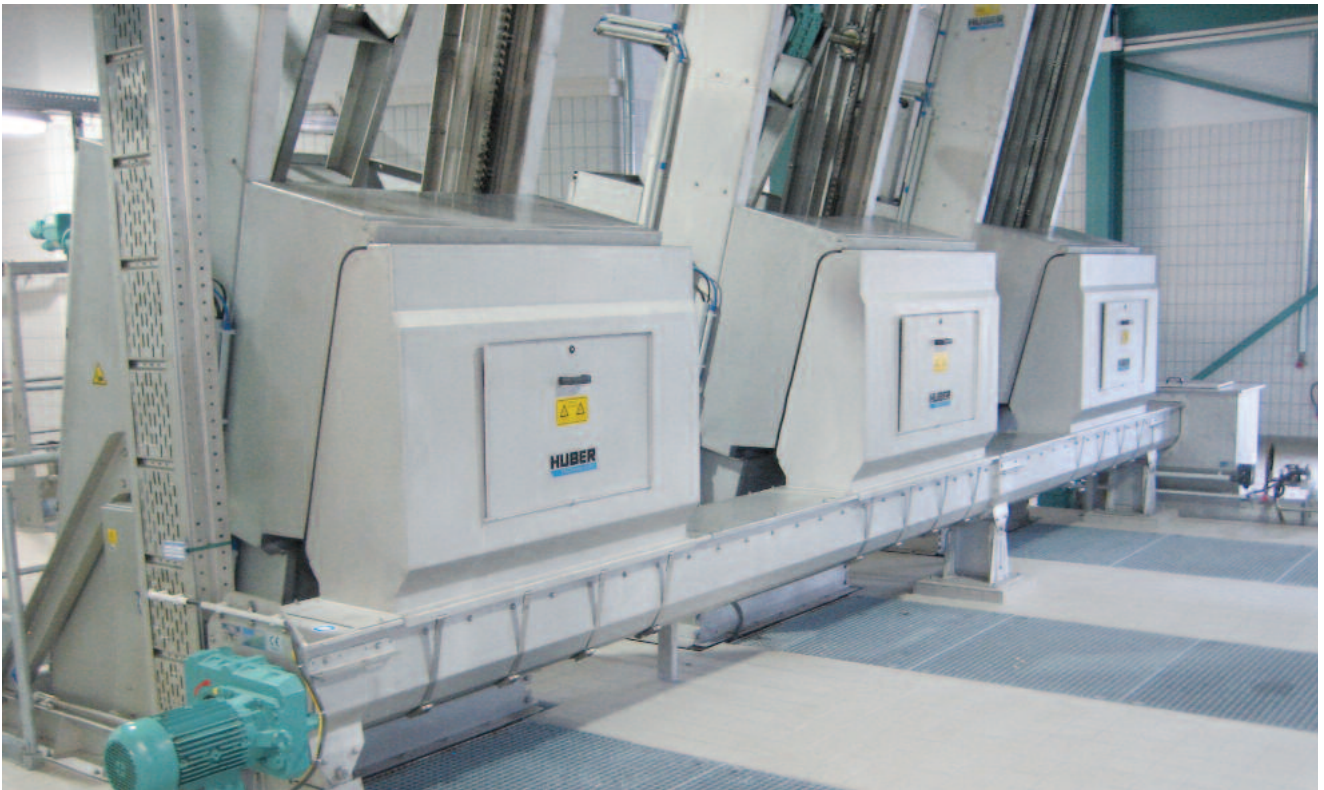
Kolme välppää poistaa välpeet ROTAMAT® Ruuvikuljettimelle Ro 8t
