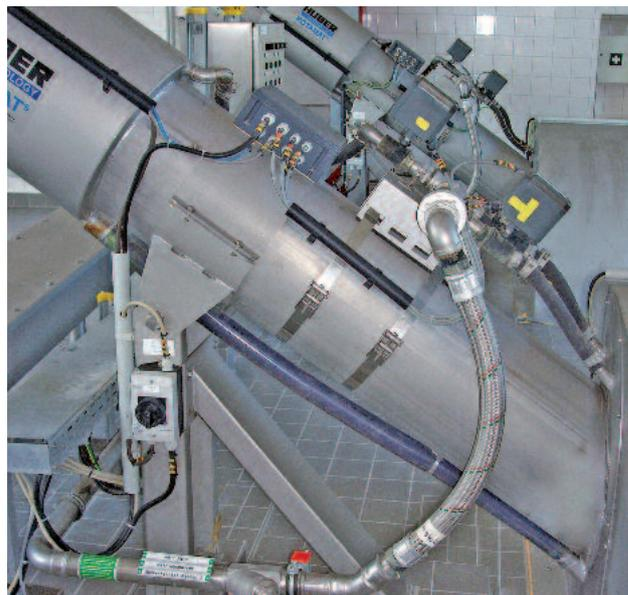
*Tamiz de finos HUBER ROTAMAT® Ro 1 con sistema de lavado de residuo integrado (IRGA) instalado en canal.*
