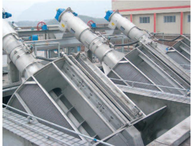
Varios tamices de finos HUBER ROTAMAT® Ro 1 instalados en paralelo en canal.
