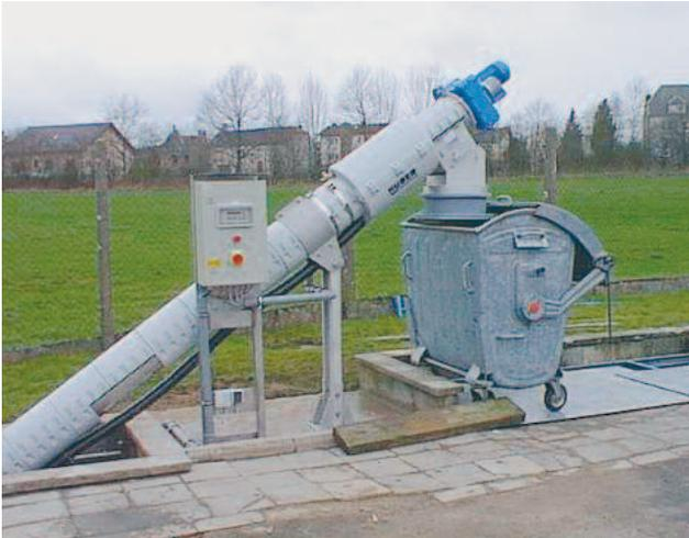
Instalación al aire libre de un tamiz de finos HUBER ROTAMAT® Ro 1 con protección antiheladas.
