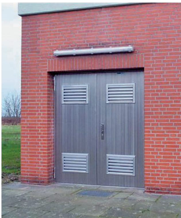
Einbruchhemmende Tür Typ TT2.2, je zwei Jalousien pro Türflügel
