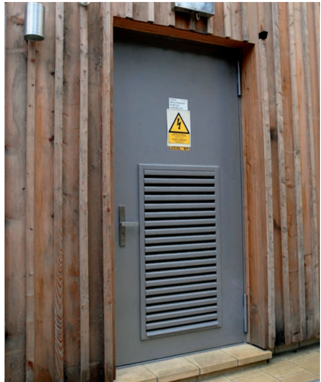
Außentür Typ TT1.1, mit Jalousie, lackiert
