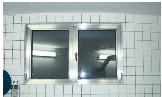
Flügelrahmenfenster, thermisch getrennt, zweiflügelig, Typ F 3
