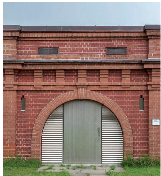
Einbruchhemmende Tür Typ TT2.1, mit Segmentbogen und seitlicher Ausfächung
