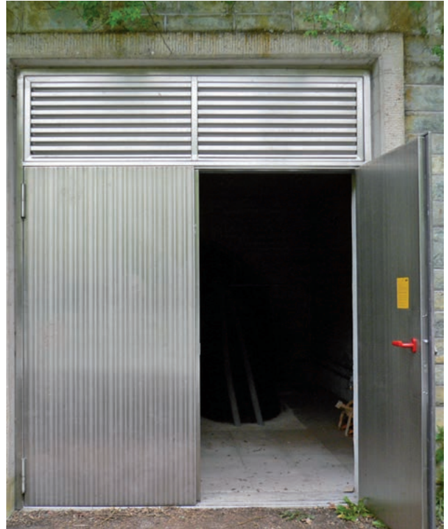
Einbruchhemmende Tür Typ TT2.2, Oberlicht als Jalousie ausgeführt
