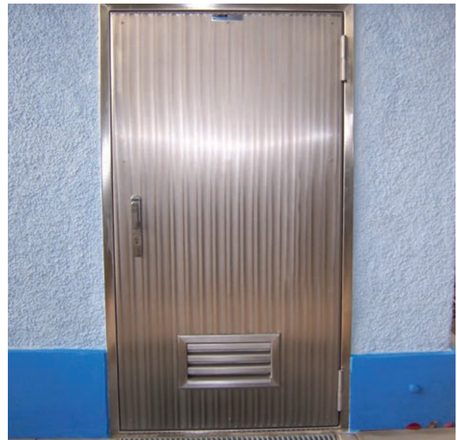
Einbruchhemmende Tür Typ TT2.1, mit Jalousie
