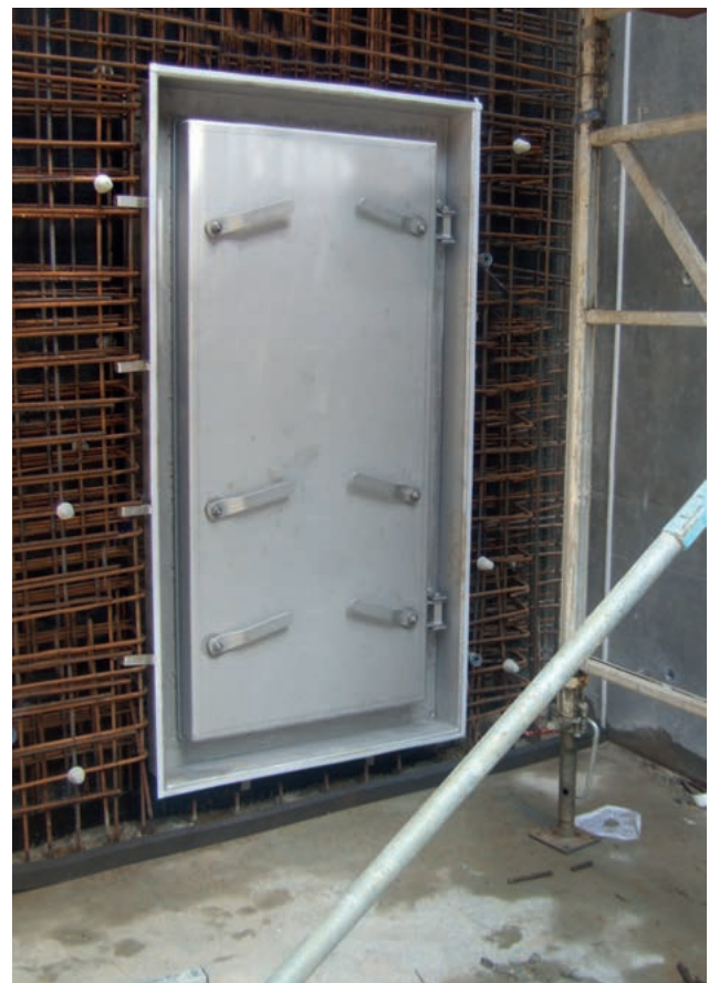
Drucktür Typ TT7, mit Einreiberverschlüssen, vor dem Einbetonieren
