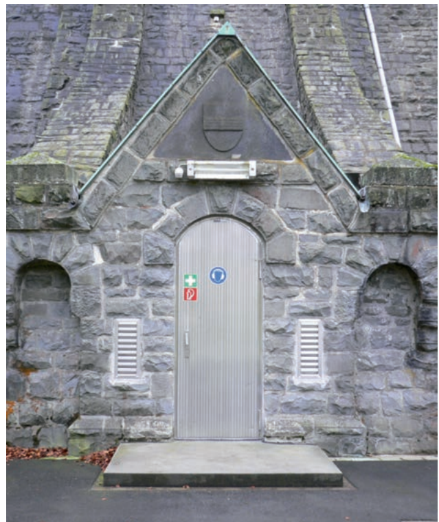
Einbruchhemmende Tür Typ TT2.1, mit Rundbogen, Jalousien starr Typ TT10
