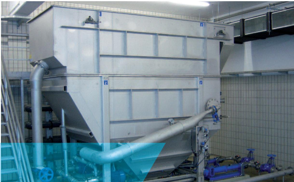
Traitement des eaux usées, récupération et recyclage de l'eau grâce au procédé de flottation avec micro bulles d'air
