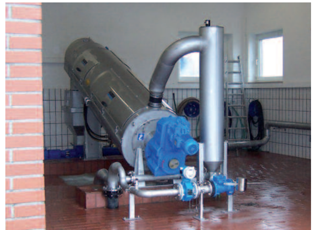
ROTAMAT® Ruuvikuivain RoS 3 , kapasiteetti 8 m 3 /h
