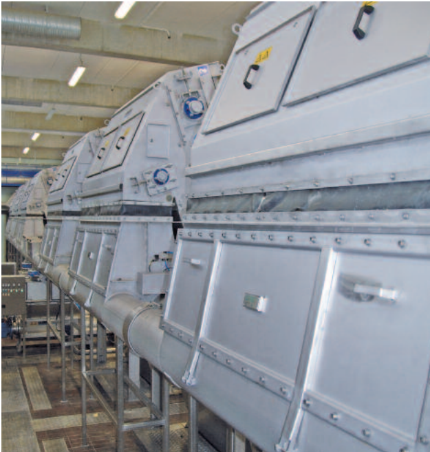
HUBER EscaMax® levynauhavälppän takaosa ja alla vesikouru, jossa välppeet kuljetetaan jatkokäsittelyyn
